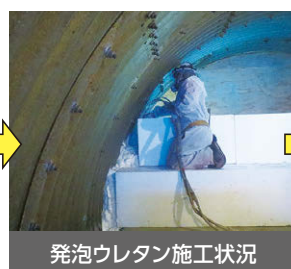
EPSブロック施工状況
